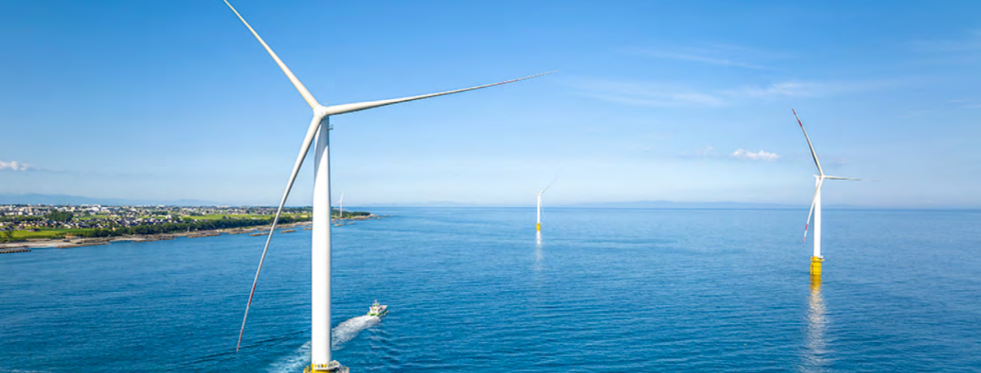
入善洋上風力発電所
