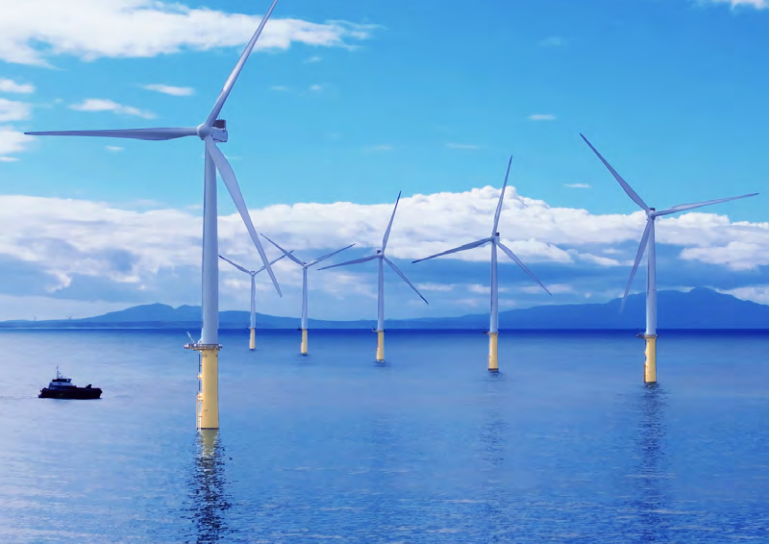
能代港洋上風力発電所(秋田洋上風力発電株式会社)
